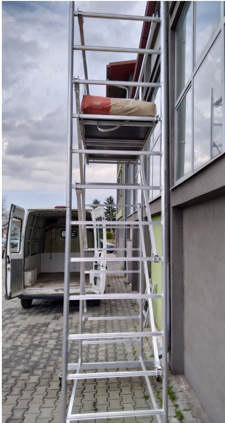
Слика 5 Праћење нагињања скеле услед тест оптерећења
